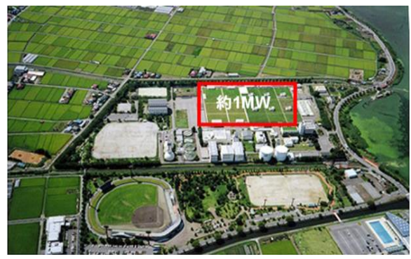
地域主導型メガソーラー事業「豊田終末処理場」 Solar Power project in a sewage facility
